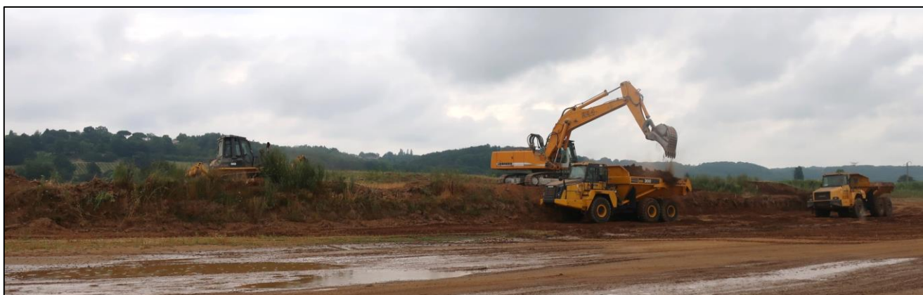
Opération de décapage Source : ARTIFEX, juillet 2020
